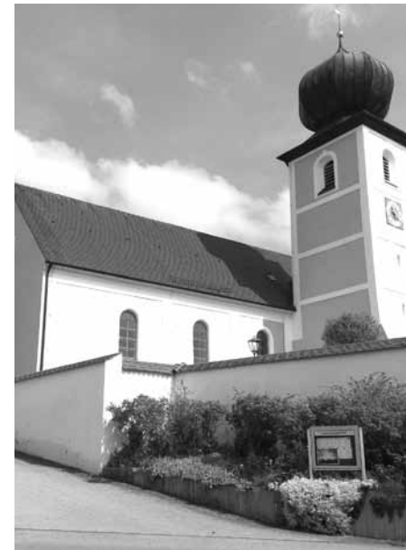
Ein Gotteshaus mit langer Baugeschichte.
